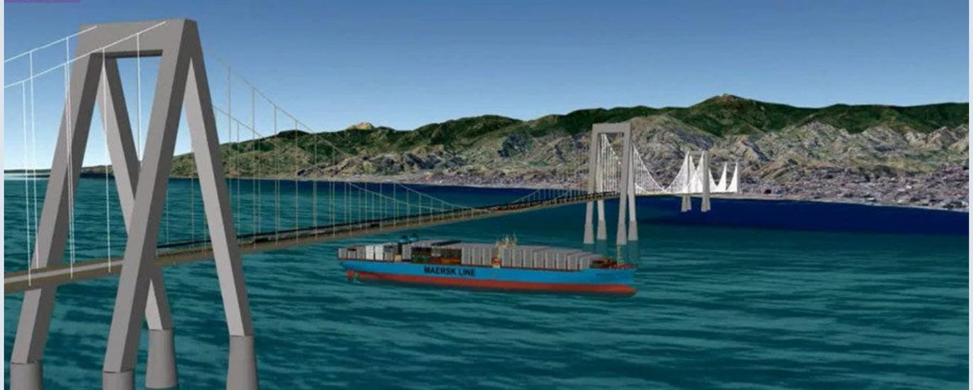
Tra le 43 alternative esaminate per superare tale tratto di mare largo 4100 m e profondo 450 m circa è stata presa in considerazione la soluzione di realizzare un ponte sospeso a due campate da 2000 m con fondazione fissa lungo il corridoio 2 utilizzando la tecnologia GBS (Gravity Basic Structure).
